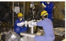
設備機器の点検及び更新
